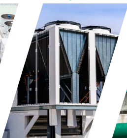
Groupes frigorifiques à refroidissement par air
