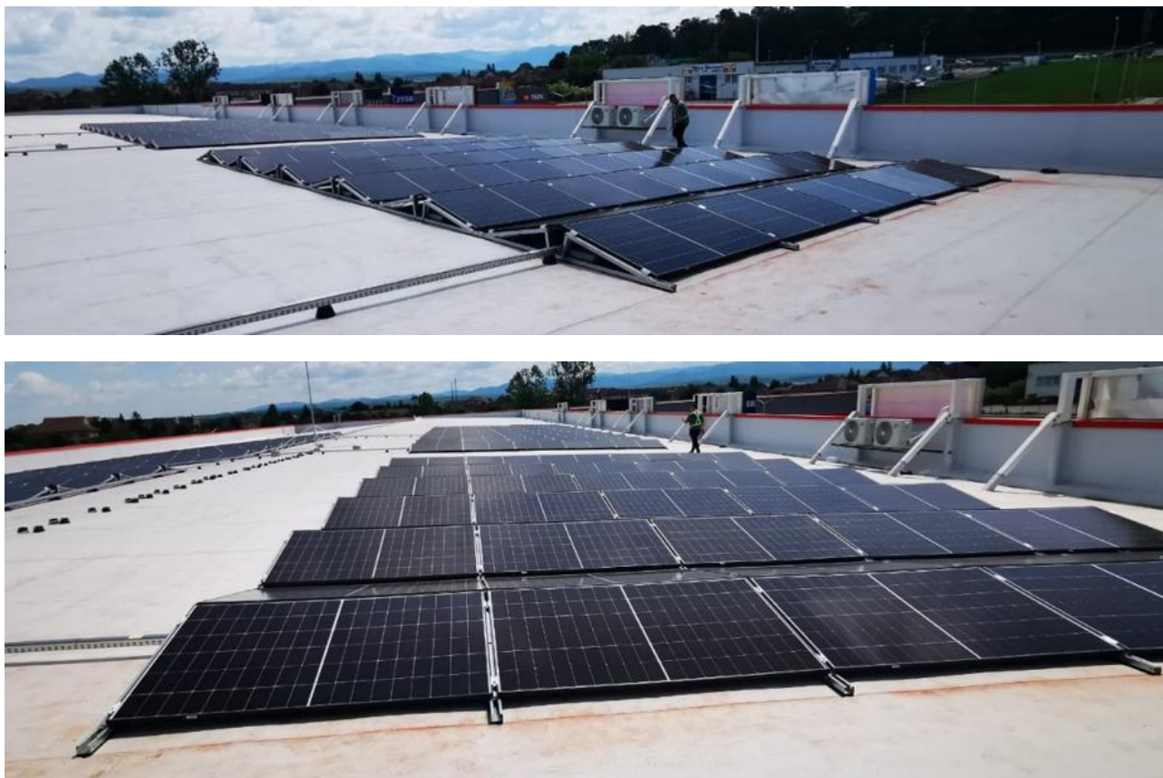
Fig. 13. Propunere: structura Avasco Est-Vest
